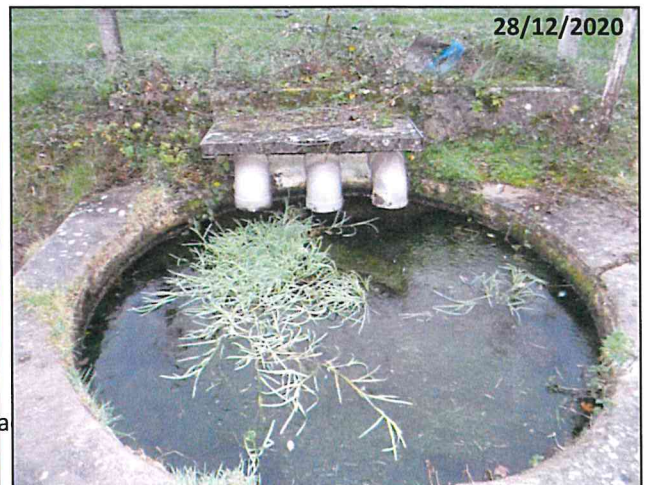
Ci-dessous : Les 3 exutoires des 3 canalisations de trop-plein des 3 puits de captage 1, 2 et 3
